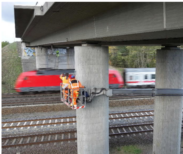
Bohrkernentnahme an einem Brückenpfeiler
